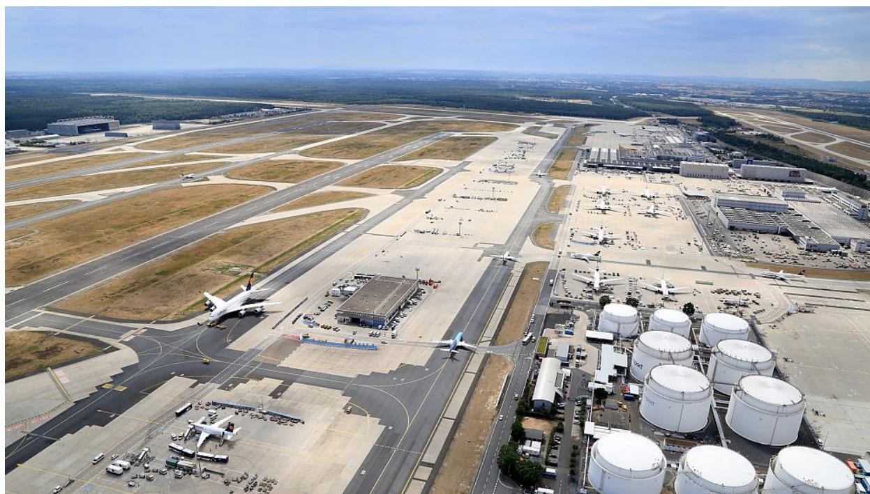
Der Frankfurter Flughafen aus der Luft. Rechts vorne zehn Kerosintanks mit einem Fassungsvermögen von 186 Millionen Litern. (Quelle: Fraport AG / Fototeam Stefan Rebscher)
