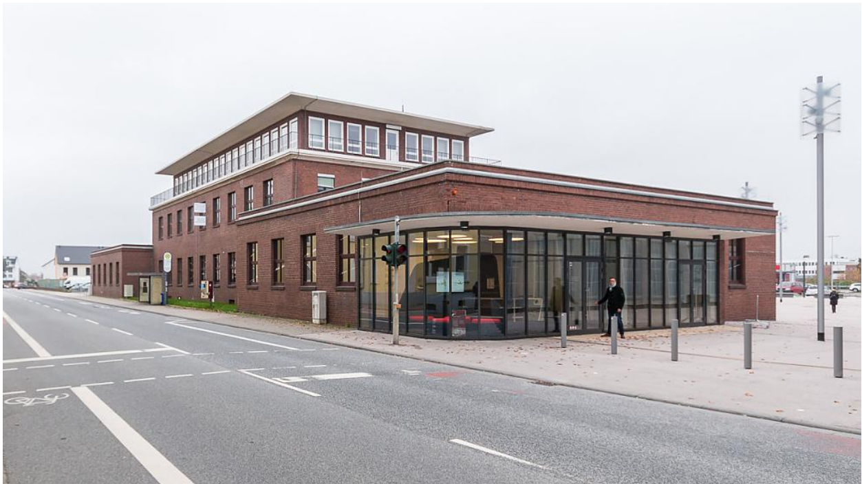
Das Umwelt- und Nachbarschaftshaus in Kelsterbach. (Quelle: UNH / Martin Kraft)
